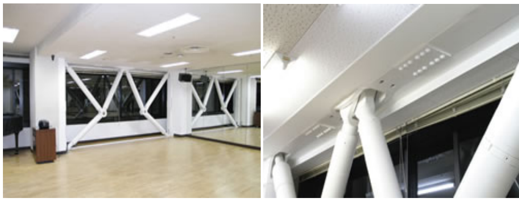
在地舖加上抗震鋼筋和加入大量的螺絲可以令結構變得非常穩固
